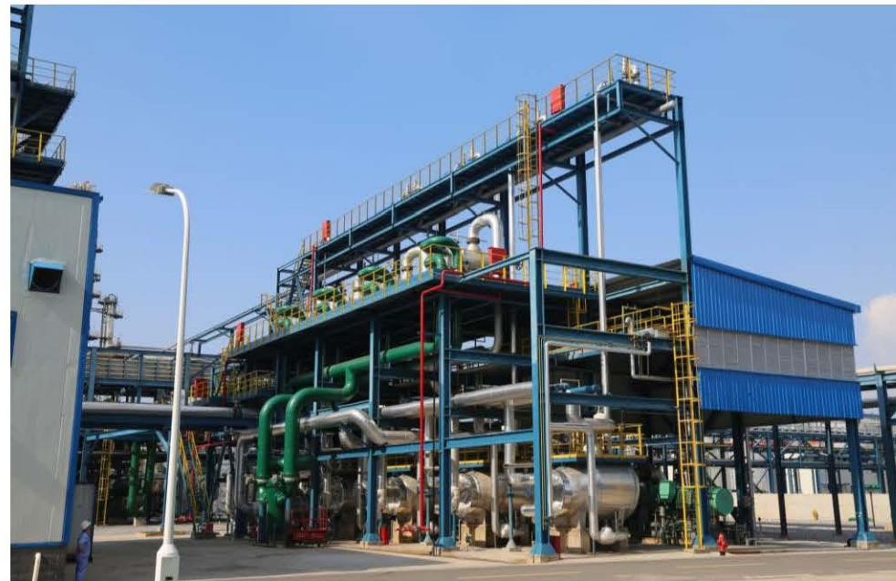
低温余热ORC发电机组工程样机(1600kW)
