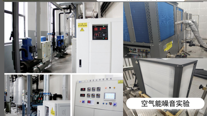
空气能检测中心
