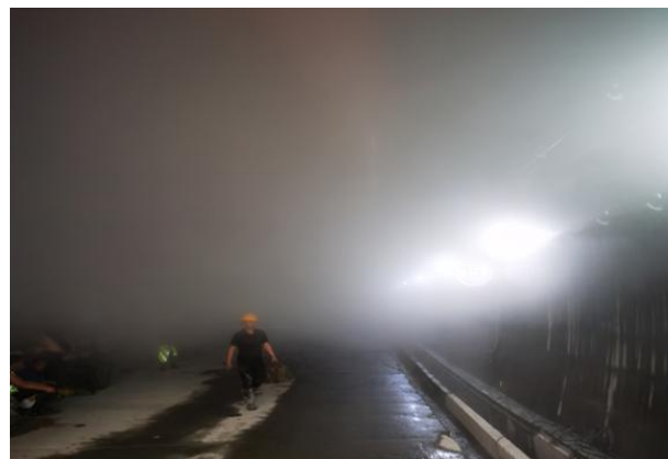
某隧道高地温段高温湿环境情景
