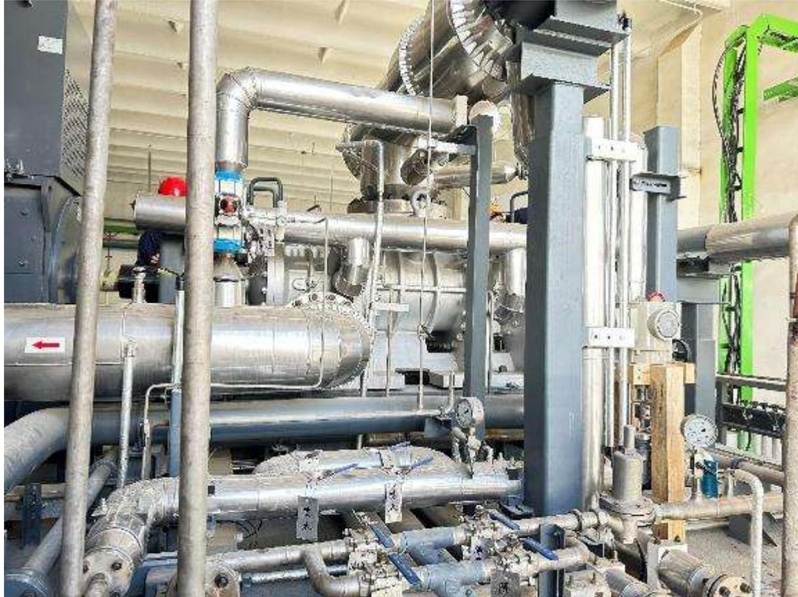
采用1台大容量水蒸气螺杆高温热泵，产0.8MPa、7t/h水蒸气，**制热COP=8.2**
